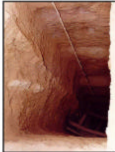
Puits à section carrée en voie de soutènement
