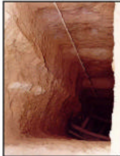
Puits à section carrée en voie de construction
