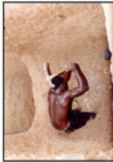
Creusement manuel de puits à sondages verticaux. On ne s'arrête
