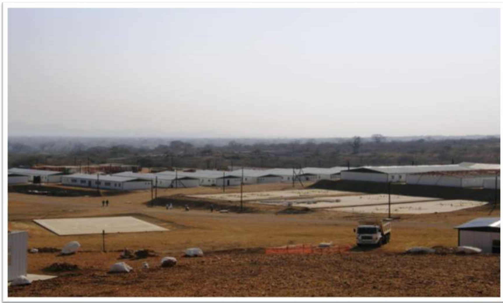
Vista geral Alojamentos B e C
