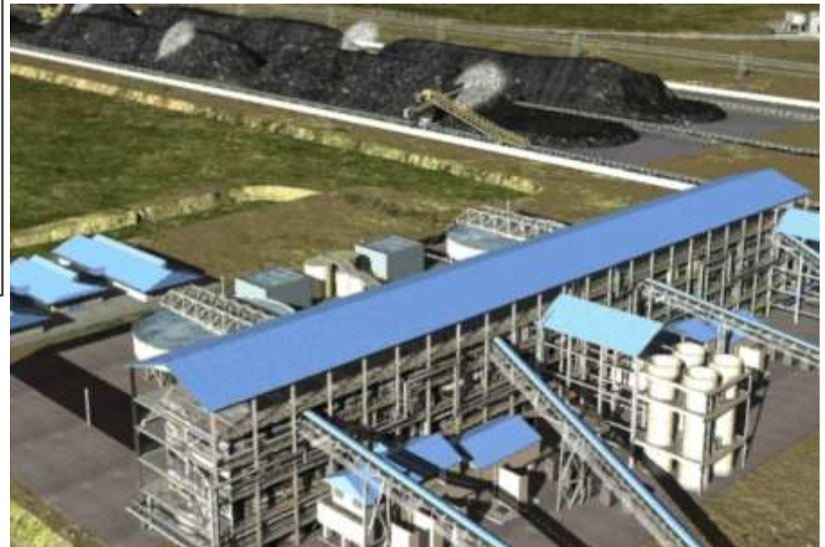
Planta de processamento de carvão
