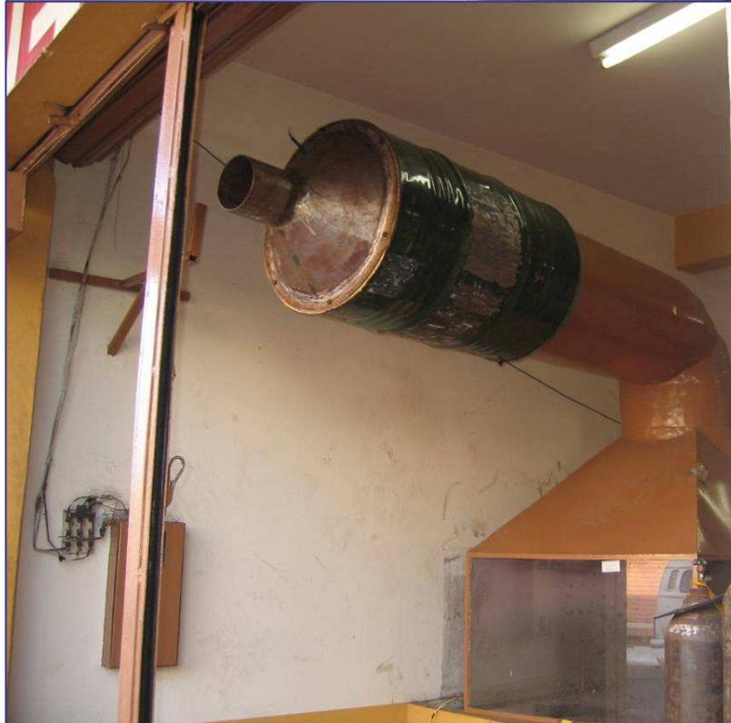
**FIGURA 4-4** Ejemplos de la instalación vertical y horizontal de los sistemas colectores de mercurio (fotos)
